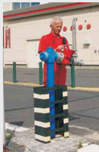
Pomiar wydatku i ciśnienia sieci hydrantowej
